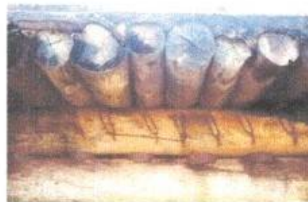
Figura 17 - Tabuleiros compostos de peças roliças de madeira e concreto Fonte: Calil Junior (2006 p. 46).
