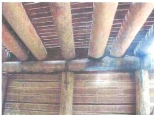
Figura 3 - Vista interior Ponte Estrada Floresta - Piracicaba/SP Fonte: Calil Junior (2006 p. A11).
