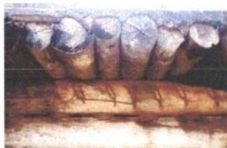
Figura 17 - Tabuleiros compostos de peças roliças de madeira e concreto Fonte: Calil Junior (2006 p. 46).
