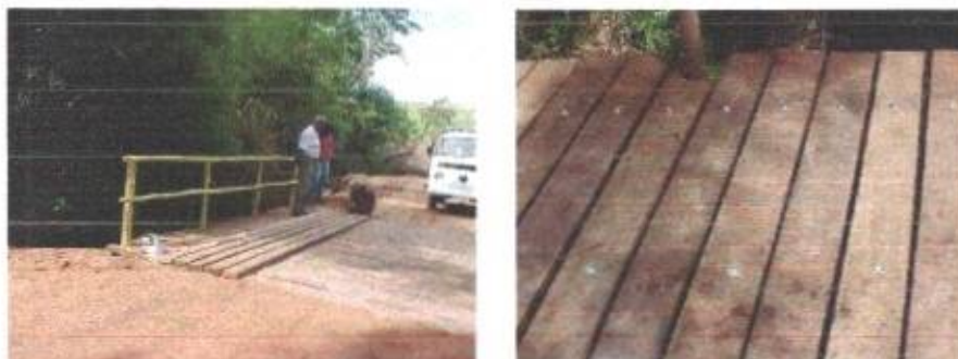
Figura 14 - Tabuleiros transversal e longitudinal de pranchas de madeira serrada
