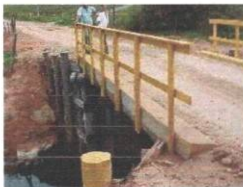
Figura 16 - Ponte com tabuleiro misto de madeira e concreto Fonte: Calil Junior (2006 p. A15).
