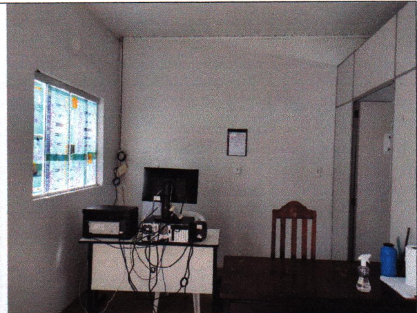
Foto 02: Remoção de divisória.
