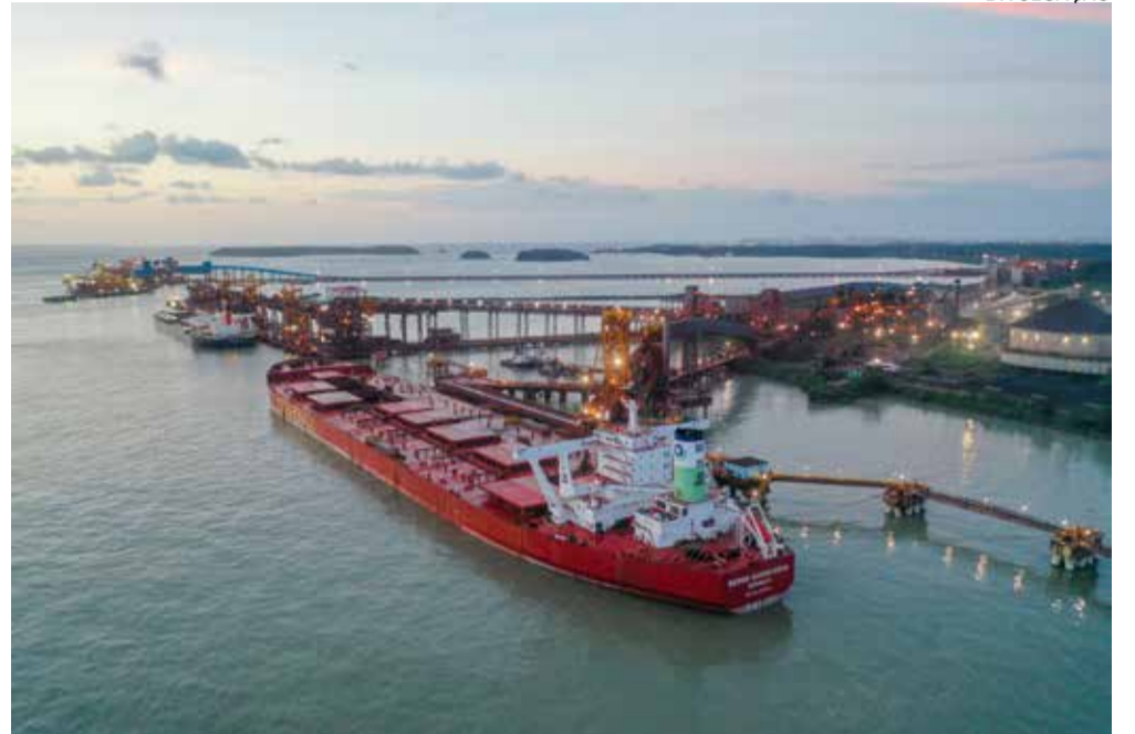
Boa atuação do Terminal da Ponta da Madeira está ligada às condições favoráveis que São Luís tem para o setor industrial
