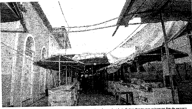
Lonas que cobrem barracas de feirantes instaladas na Praia Grande cederam devido às fortes chuvas que caíram no fim de semana
